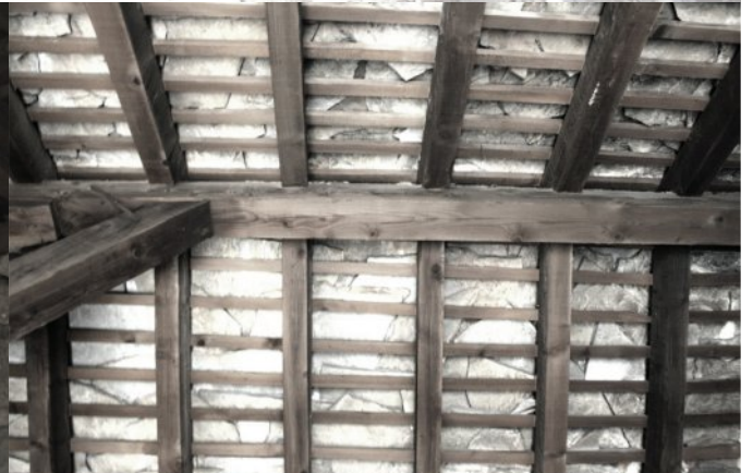
krovište "didove kuće" 61
